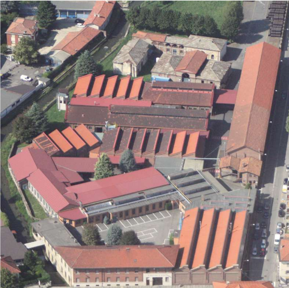
Usine de Pinerolo (Turin)
